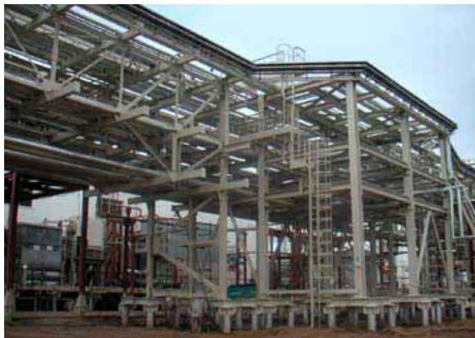
Металлоконструкции эстакады для трубопроводов Южно – Шапкинское нефтяного месторождения (2003г.), полиуретановая система покрытия на основе цинкнаполненной грунтовки ЦИНОТАН
