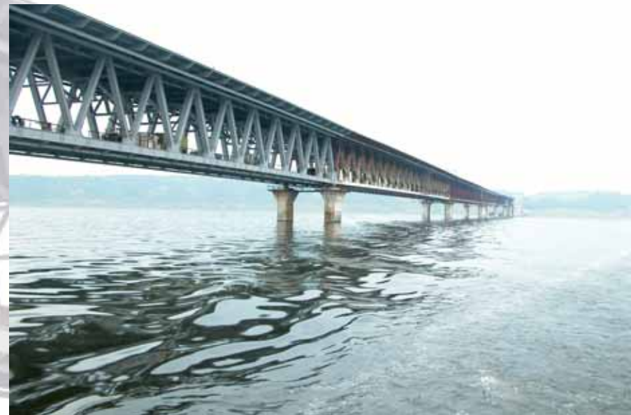
Рис. 1. Строительство мостового перехода через Волгу в Ульяновске. Покрытие – полиуретановые материалы ВМП
