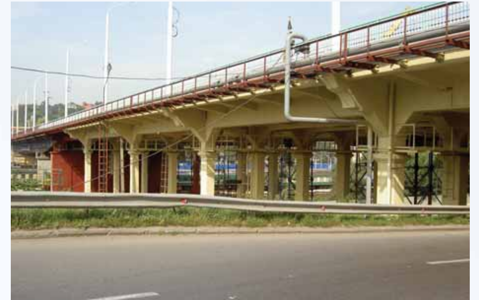
Рис. 2. Мост-путепровод в створе проспекта Стачки в Ростове-на-Дону. Покрытие – полиуретановые материалы ВМП
