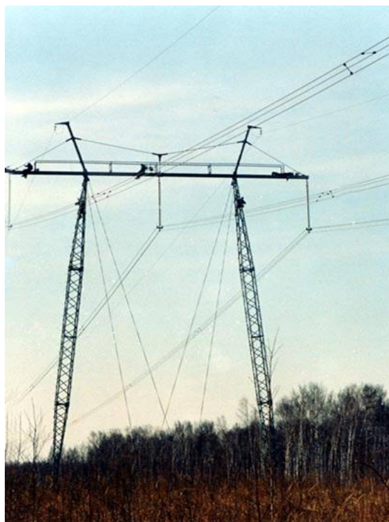
Рис. 4. Окраска материалами Цинол и Алпол опор ВЛ в полевых условиях с привлечением промышленных альпинистов во время ремонта
